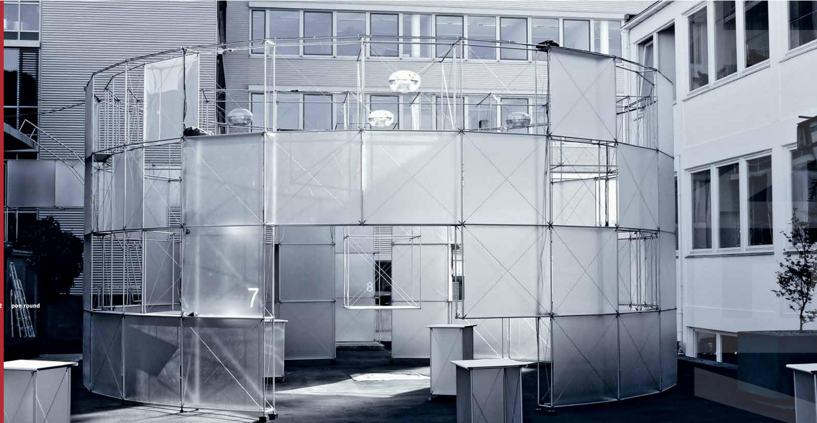
Mit einem Außendurchmesser von fast zehn und einer Bauhöhe von beinahe fünf Metern stellt diese Rotunde aus pon round eine alternative Bauform dar – geeignet zum Einsatz auf Messen, in Museen und Events. Ihr Durchmesser beträgt ca. 80 m<sup>2</sup>
